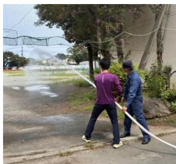
消火栓のポンプを稼働し実際に放水
